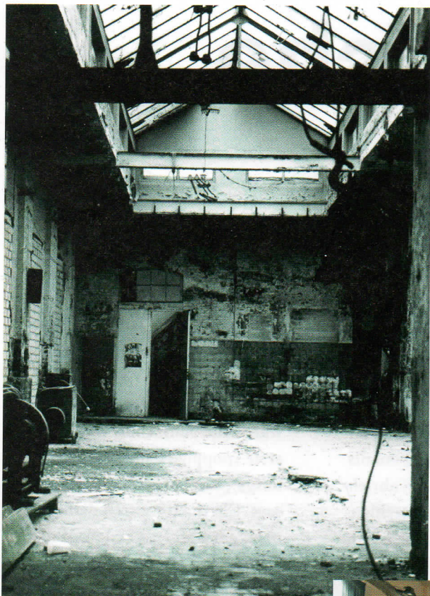
Der Lichtmeß-Saal vor dem Umbau und heute.
